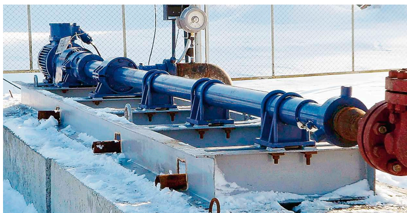
Общий вид одновинтовой мультифазной насосной установки
